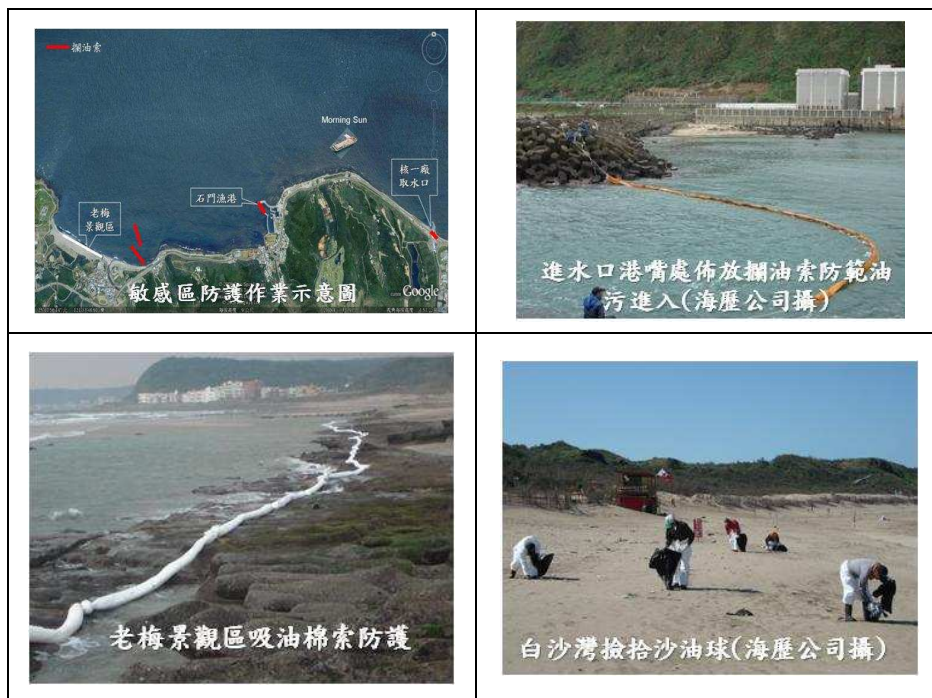
圖七 岸際污染敏感區防護作業圖
