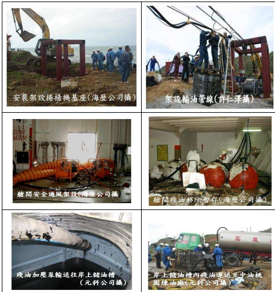
圖六 晨曦號貨輪船艙殘油移除作業圖
